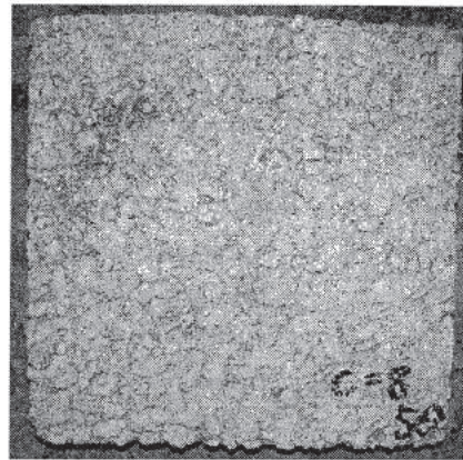
写真1 泥土固化砕石を使用した表層材料
