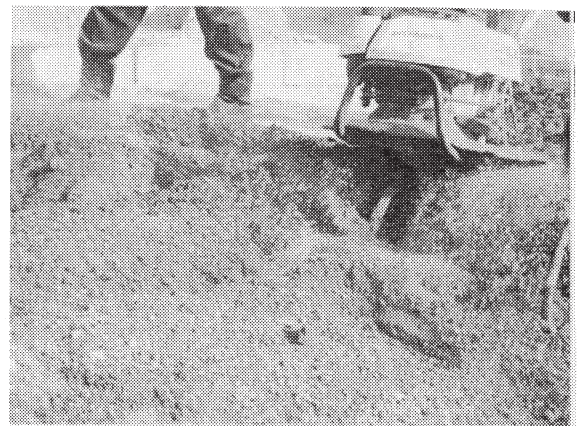
②再生舗装材の混練
