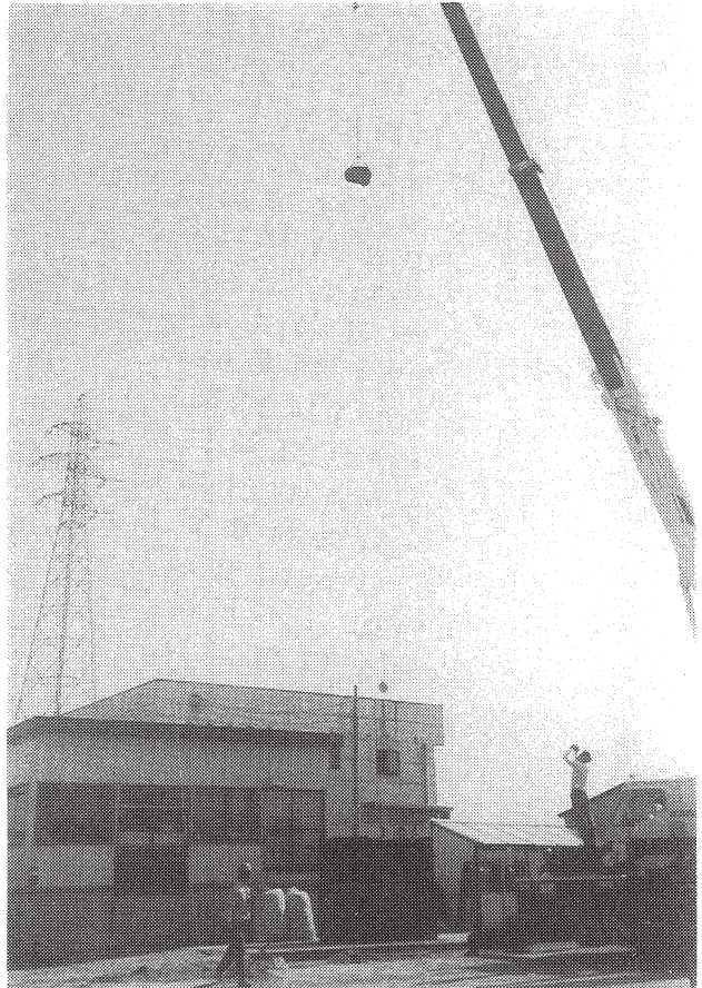
写真2 クレーンによる落下石のつり上げ
