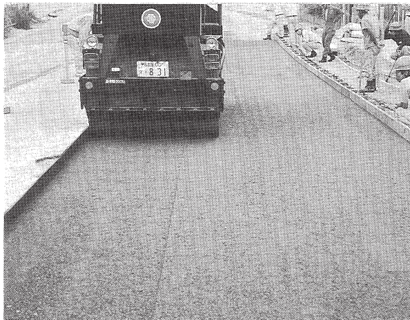
写真-2 施工状況
