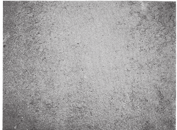
写真-3 完成路面状況
