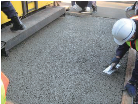
写真3 アスファルトフィニッシャによる締固めの様子
