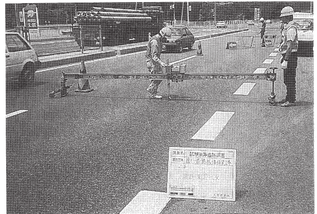
写真-27 わだち掘れ測定中の富谷バイパス
