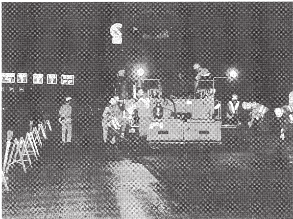
写真-24 国道4号線仙台バイパスに施工
