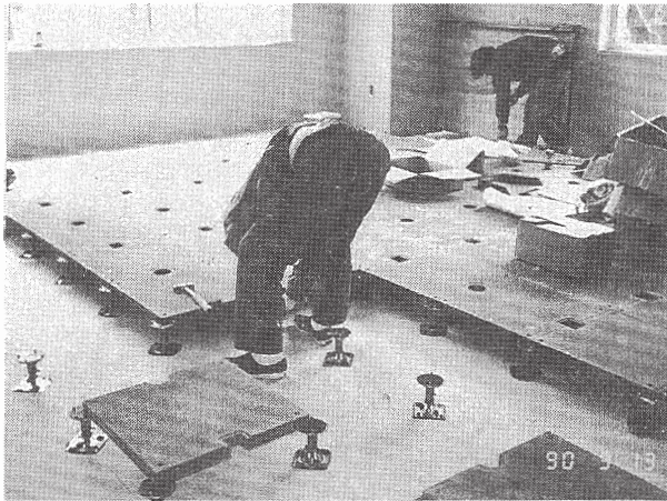
写真-8 石炭灰砂OAフロアの現場施工
