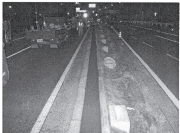
写真-5 施工完了
