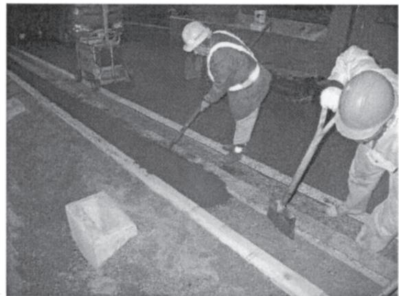
写真-4 施工状況
